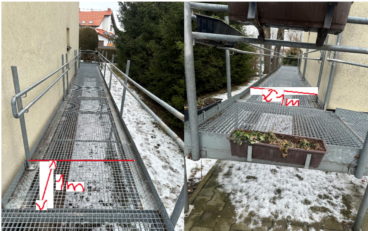
Zdjęcie nr 3 i 4.: Zmniejszenie długości pochyłego odcinka podjazdu z 11mb do 9mb
