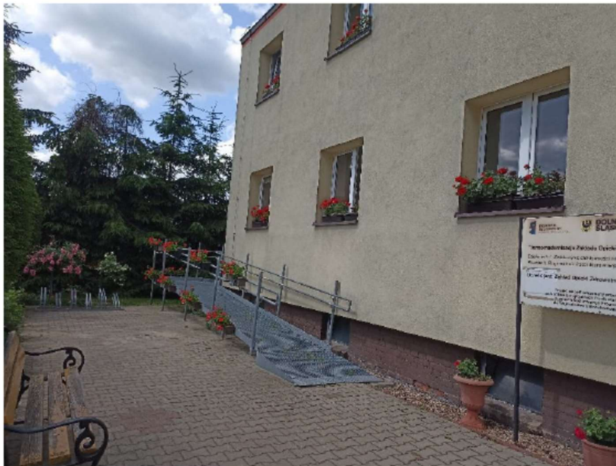
Zdjęcie nr 1.: Zniwelowanie nachylenia pierwszego odcinka podjazdu na 6% kąta nachylenia poprzez przedłużenie długości odcinka podjazdu.
