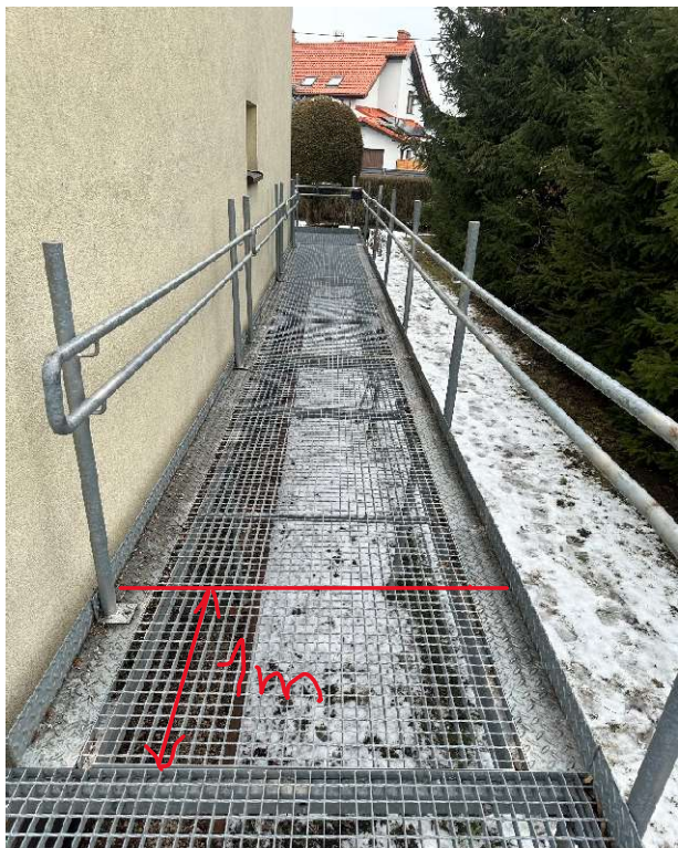
Zdjęcie nr 3 i 4.: Zmniejszenie długości pochyłego odcinka podjazdu z 11mb do 9mb
