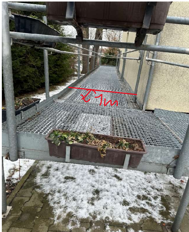
Zdjęcie nr 3 i 4.: Zmniejszenie długości pochyłego odcinka podjazdu z 11mb do 9mb
